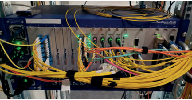
Abb. 2: WDM-Chassis OTS-5000 von Pandacom
